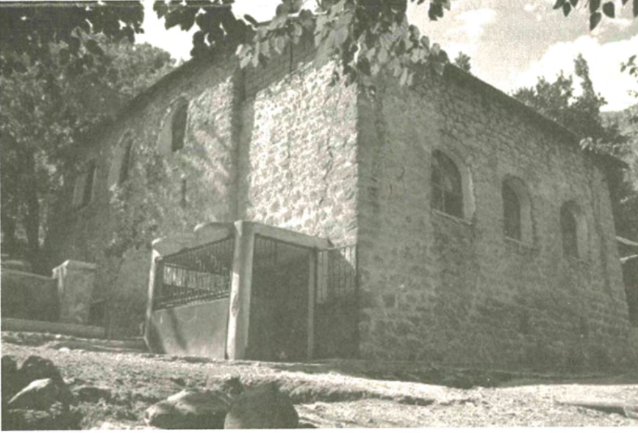
Foto 1 Hakkari Üzümcü Köyü Şeyhali Camii
