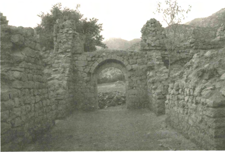
Foto 22: Hakkari Şemdinli (Nehri) Kayme Sarayı Kazı Sonrası Durumu
